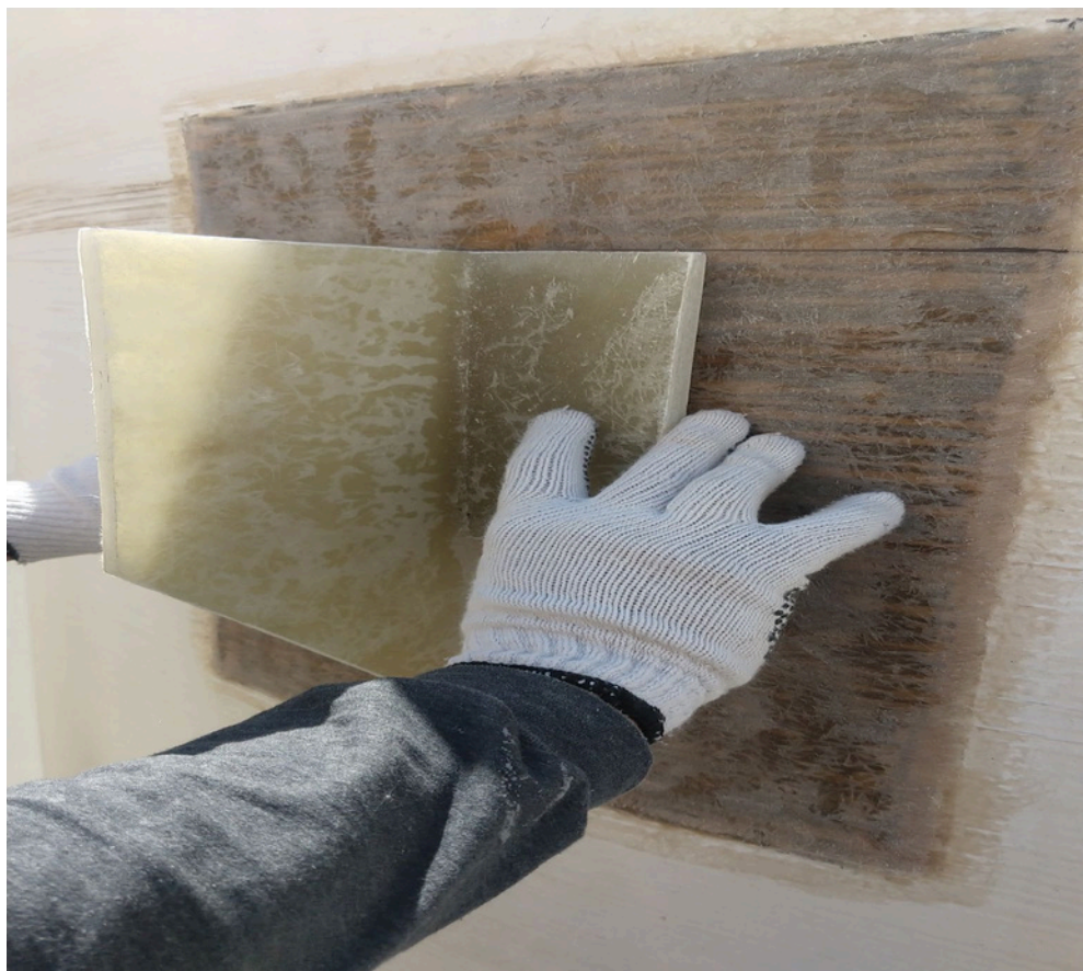
FOTO 8: Instalação de suporte para passarela em pultrudado
